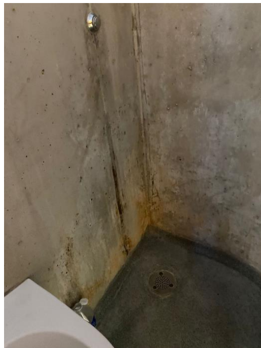
Espace sanitaire douche et wc
