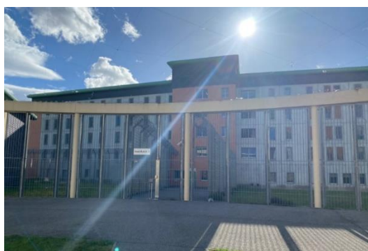
Vue sur la Maison d'Arrêt 1
